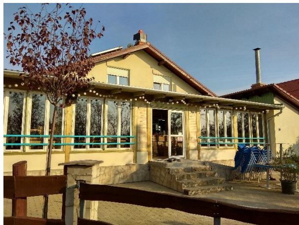
Az épület déli, Buki utca felőli homlokzata a terasszal
