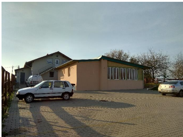
Az épület északi, 2. sz. főút felőli homlokzata
