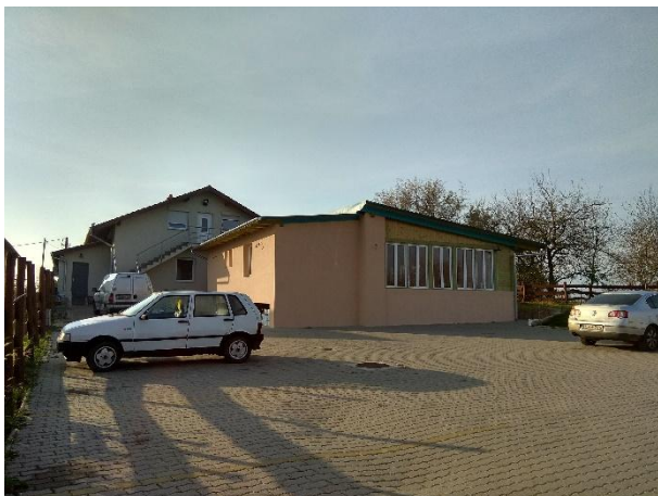
Az épület északi, 2. sz. főút felőli homlokzata
