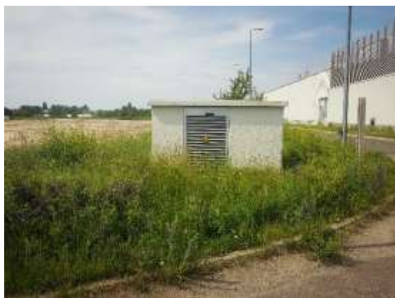
Trafóház a telek É-i részén
