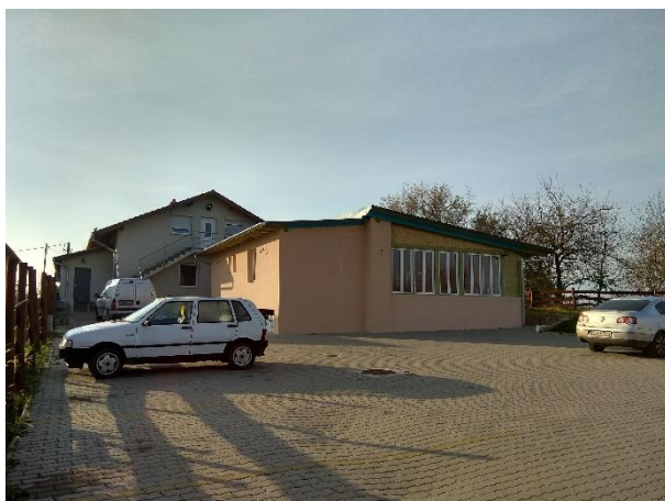
Az épület északi, 2. sz. főút felőli homlokzata
