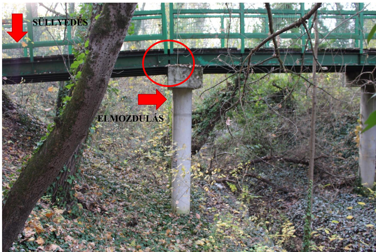
1. kép Elmozdulás a közbenső D-i támaszon
