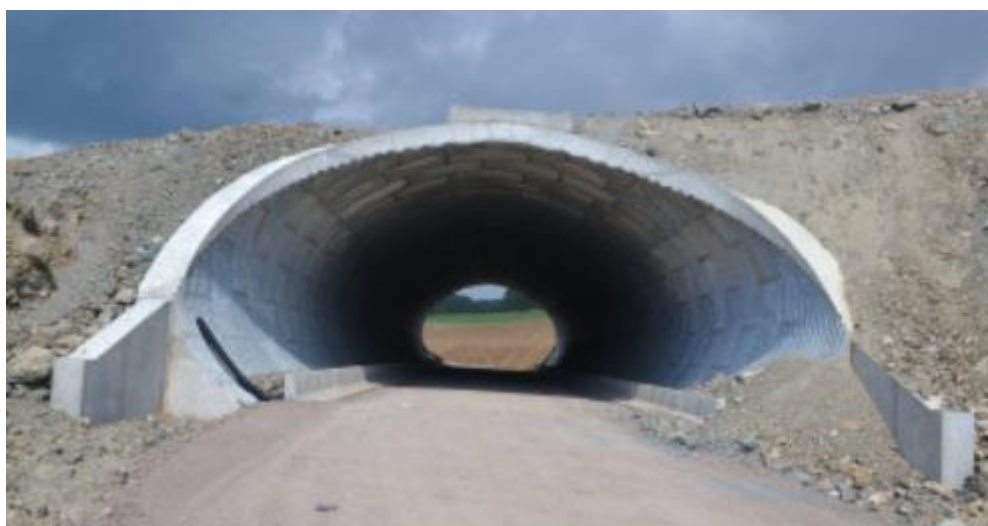
3. kép: Tubosider rendszerű átereszt kialakítása
