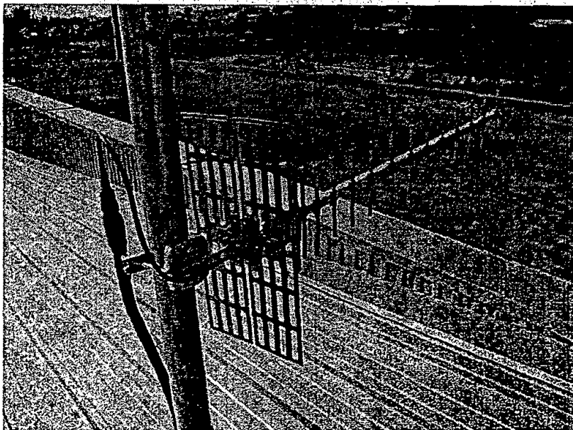
1. ábra ACY-15 típusú antenna, antenntartóra szerelten
