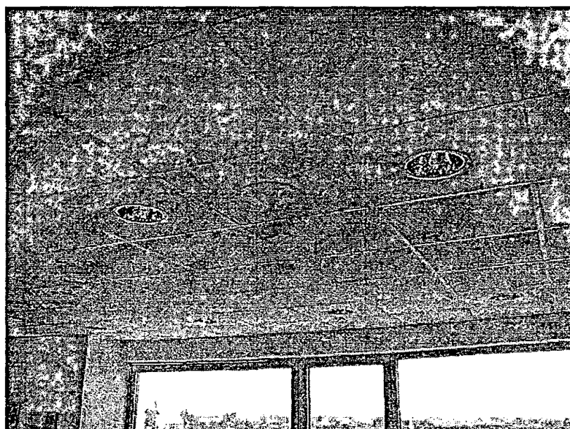
12. ábra Körsugárzó antenna álmennyezetre szerelten
