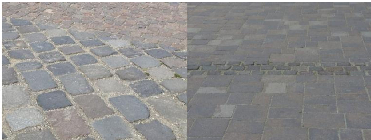
42. ábra: Rázós nagykockakő burkolat, illetve lényegesen simább térkő (Eszterházy Károly utca, Március 15. tér). A rázós úttest – sima járda kombináció a kerékpárosokat is a járdára vonzza
