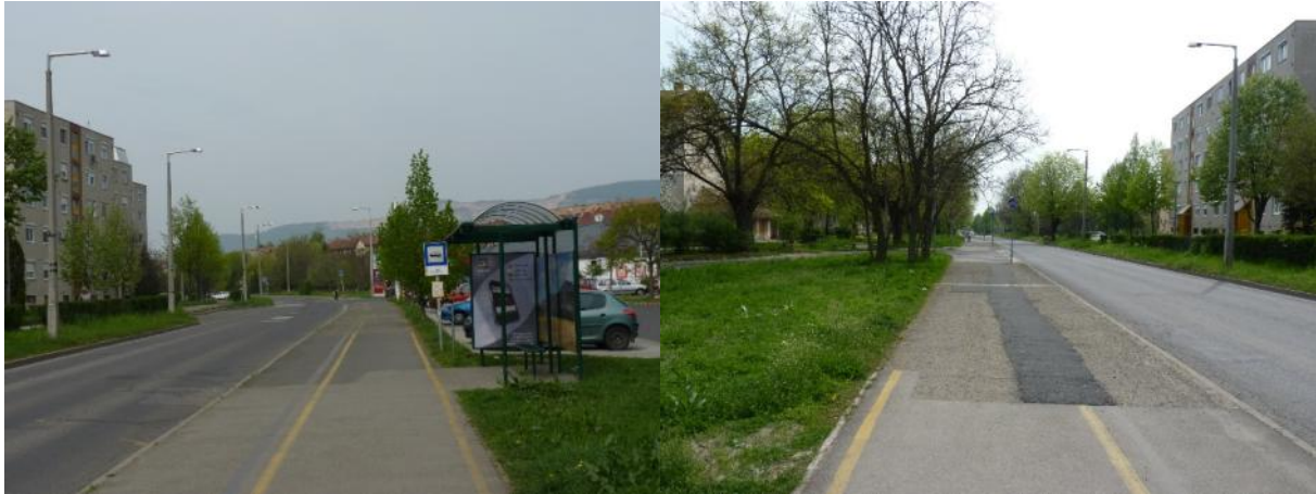
38. ábra: Járdára festett kerékpárút a Gombási út mentén
