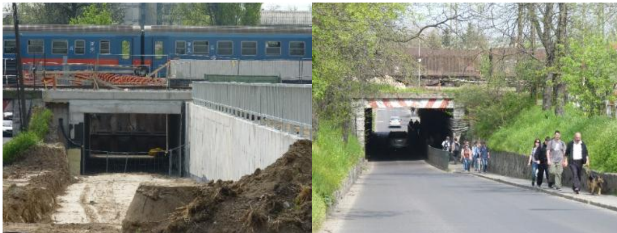
40. ábra: Az épülő Naszály úti aluljáró és a jelenlegi gyalogosforgalom
