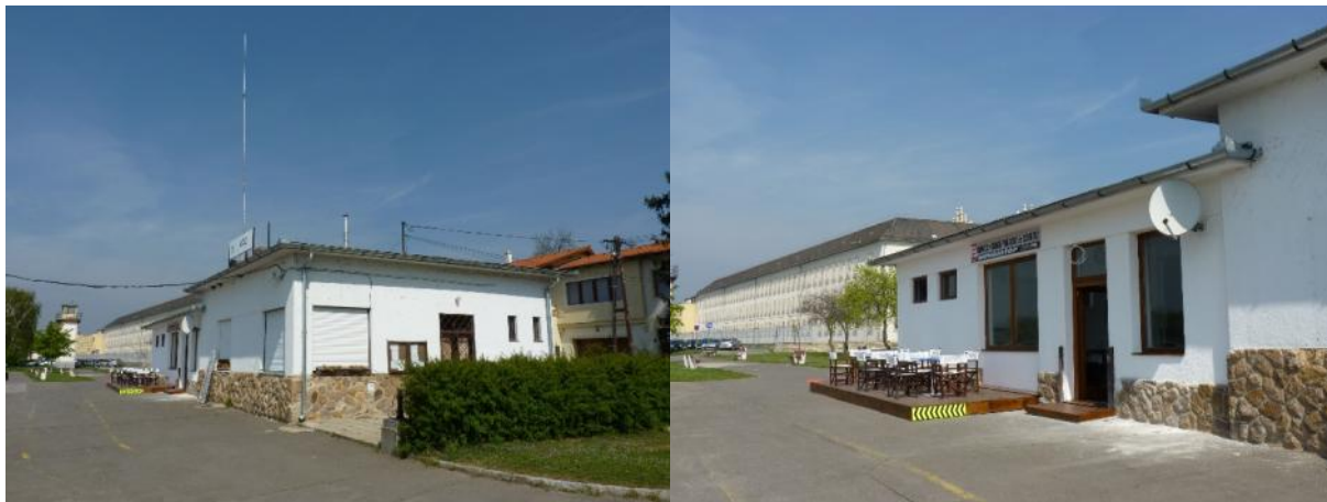
58. ábra: A meglévő hajóállomás épülete a kávézó-kerékpárszervizzel
