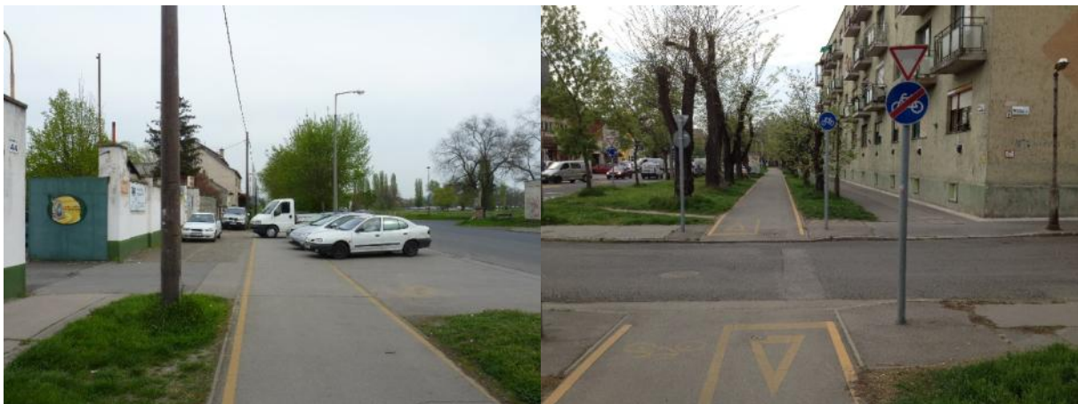
39. ábra: A meglévő kerékpárút gyengeségei: ráparkolás és elsőbbségadás mellékutcának
