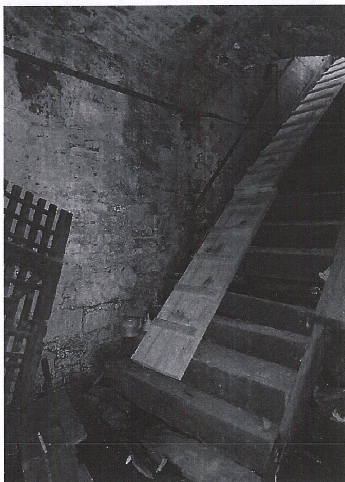
Korrodált vízvezeték, alul szétkorhadt gombásodott lépcső.
