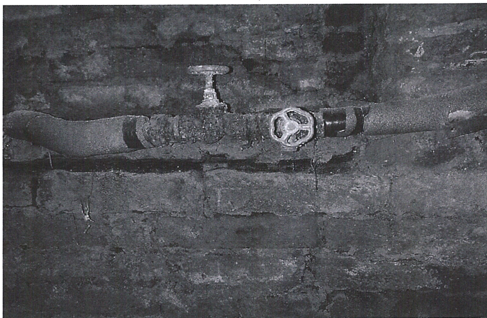
Korrodált vízvezeték, alul szétkorhadt gombásodott lépcső.
