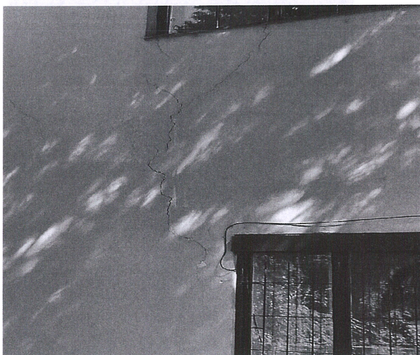
A 2.sz. lakás külső fal repedése.
