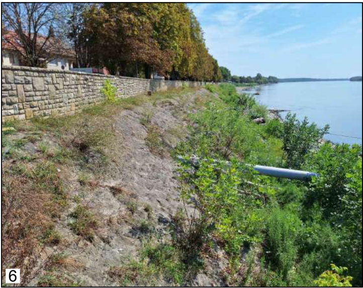
6.a. Liszt Ferenc sétány betonba rakott kőburkolatú részsű, parapetfal
