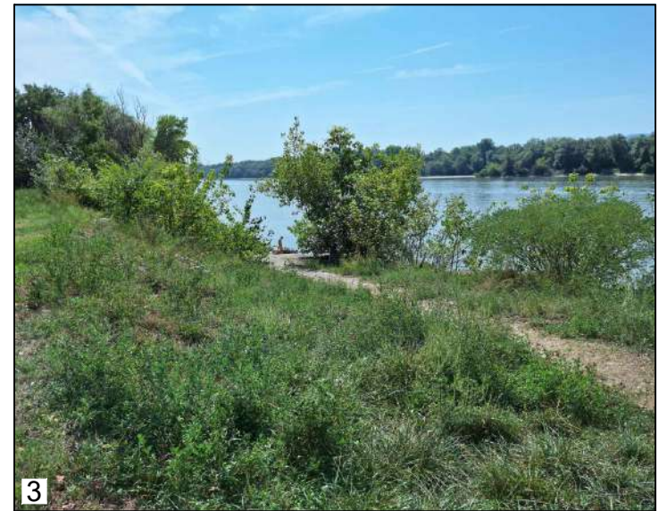
3. DDC kikötő alvízi oldalán lévő rézsús part
