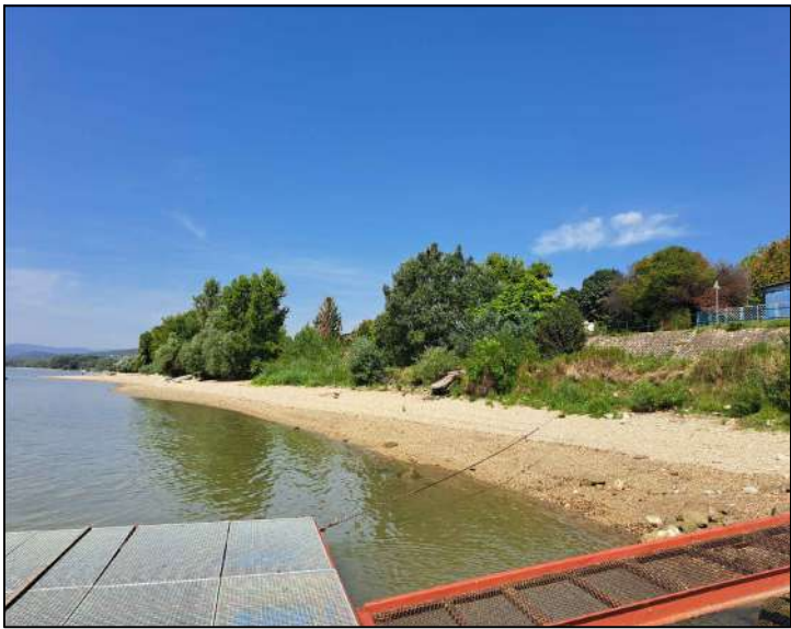
5.b. Duna utca és Barabás Miklós utca közötti partszakasz, betonba rakott kőburkolatú részsű
