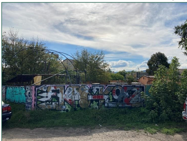
Club Mausoleum szórakozóhely kerítése a vasút felől
