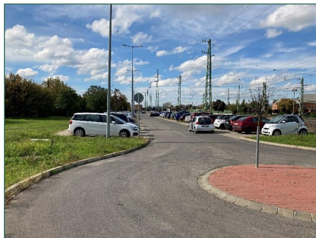
Kiépített P+R sáv Honvéd utca felőli vége
