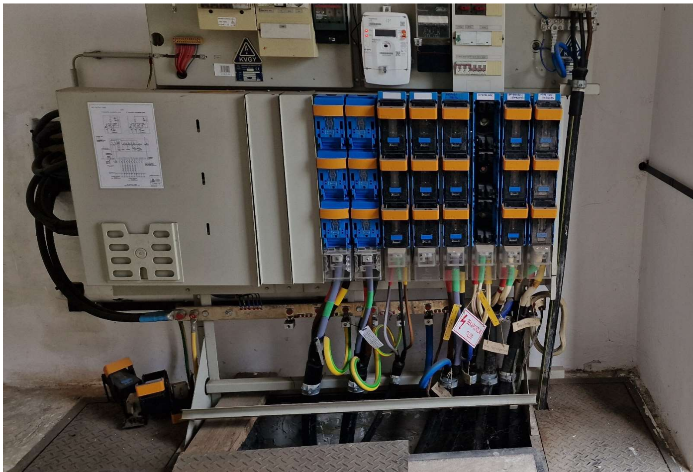
Elosztói transzformátor állomás szekunder biztosítócsoport
