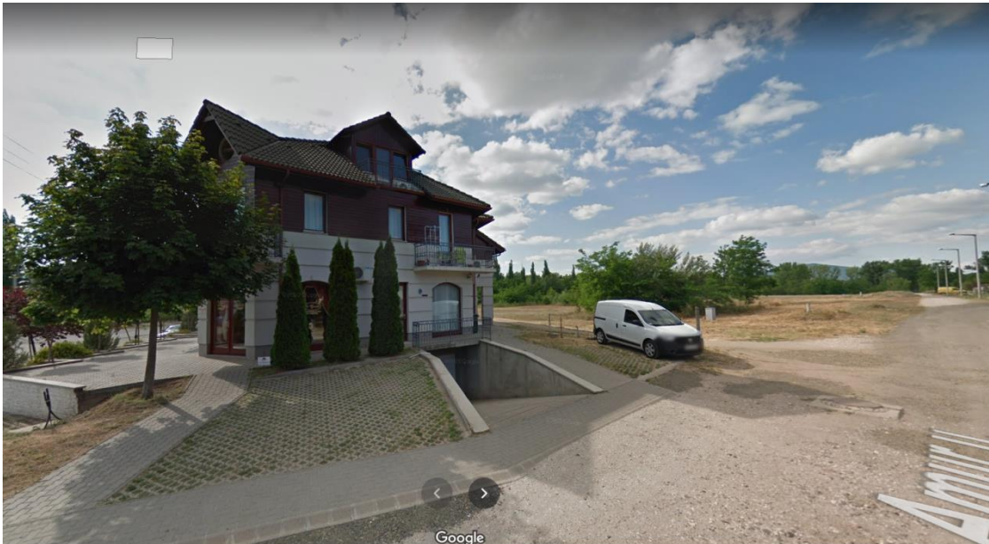
Tervezési terület 7001/70 hrsz-ú telken álló épület (forrás: Googlemaps)
