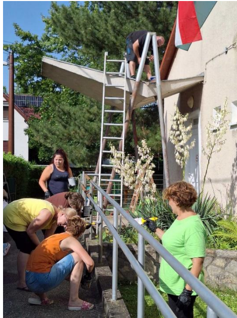
Együtt szépítjük bölcsődénket
