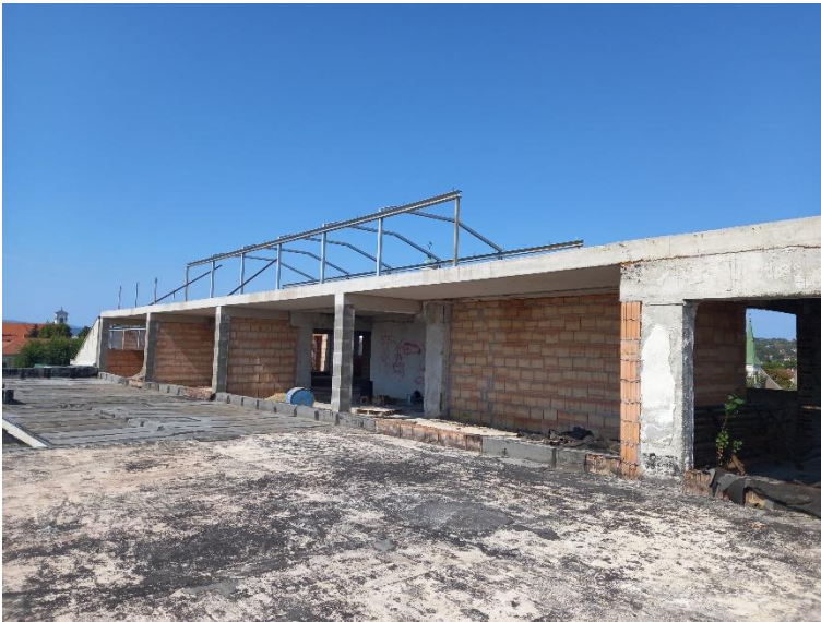
Budapesti főút felől megépült 4 emeleti szint
