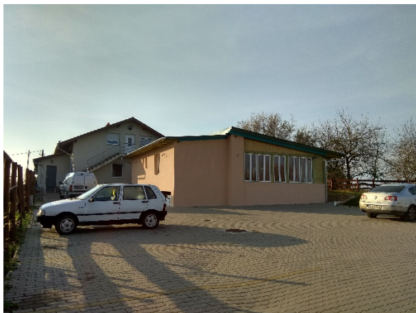
Az épület északi, 2. sz. főút felőli homlokzata
