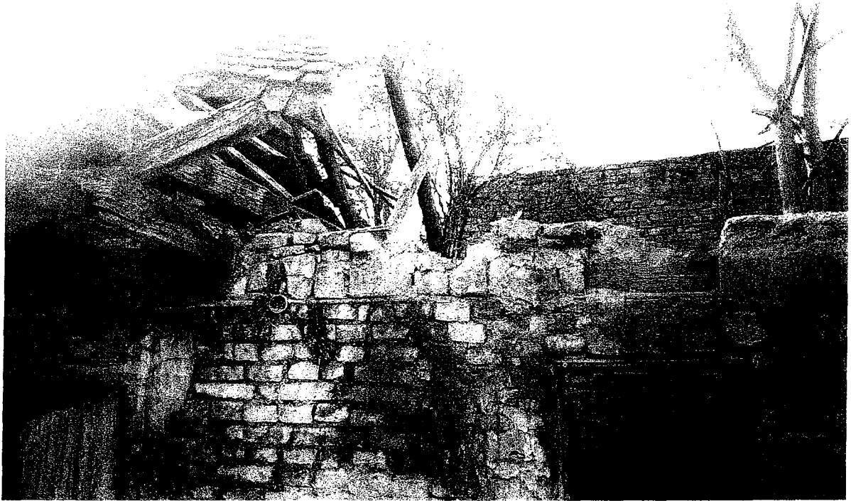
Udvari épületszárny tetőszerkezete
