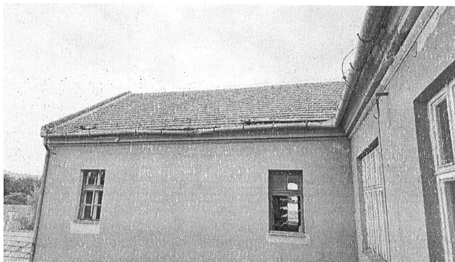
6. Károsodott ereszcsonatorna
