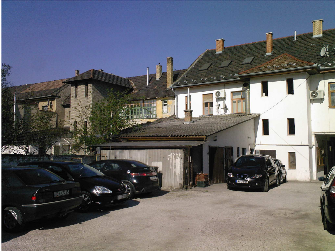
Belső udvar a szomszéd telek felől
