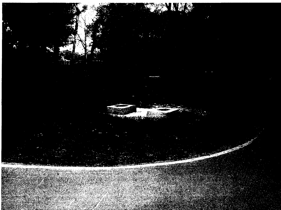
6. kép: szivattyúzási hely
