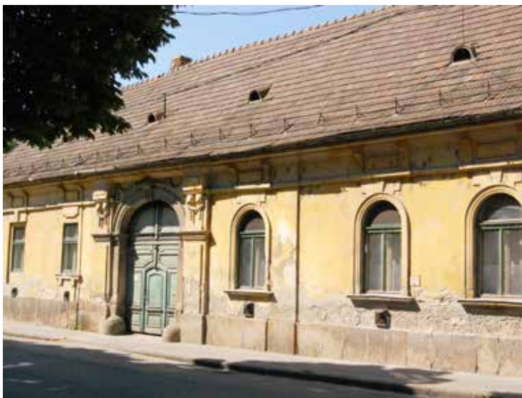
Lakóház, Budapesti főút 13.
