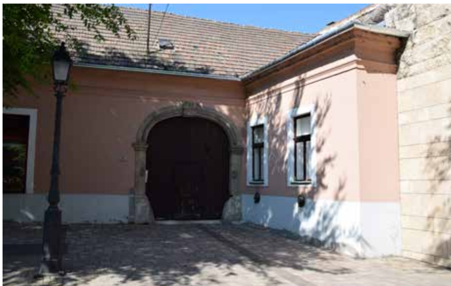
Lakóház, Köztársaság utca 32.
