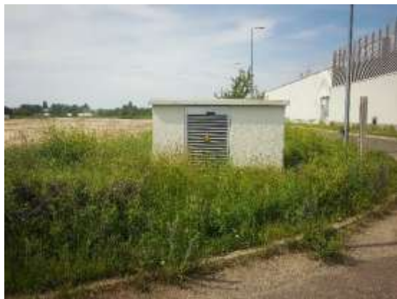
Trafóház a telek É-i részén
