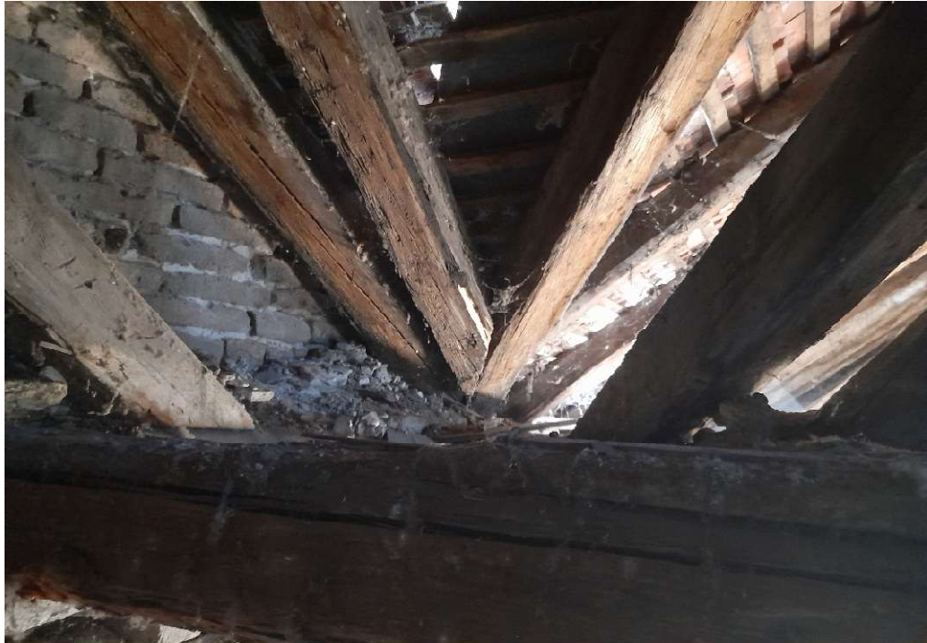
3.T. Piac oldali főtető vápa csomópont károsodása.
