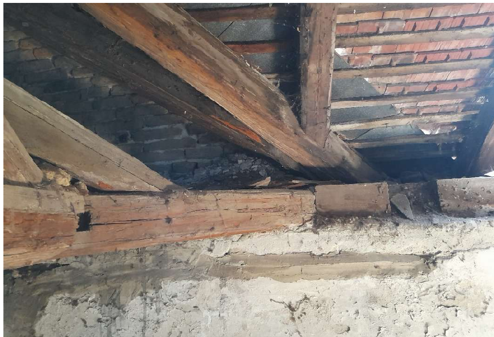
3.T. Piac oldali főtető vápa csomópont károsodása.
