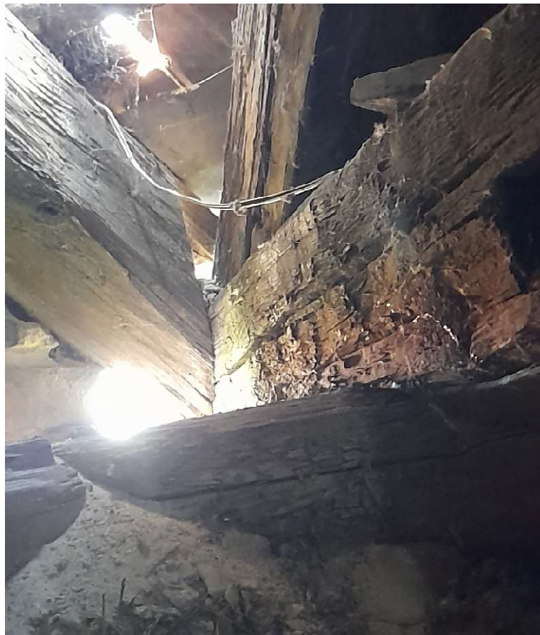
2.T Főtető, dél-nyugati sarok szétkorhadása. héjazat hiány, bádogos hiba.
