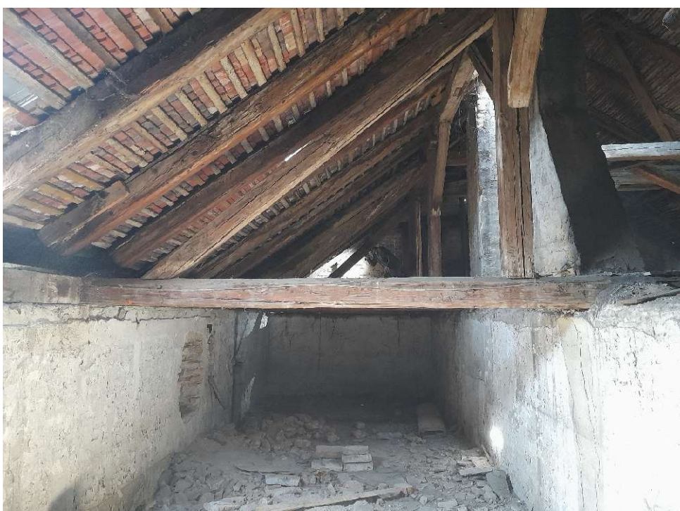
Belső, előtér feletti födém , -helyreállítandó borított gerendafödém.
