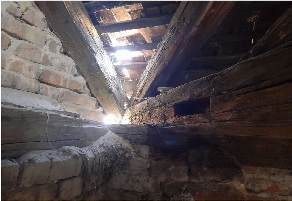
2.T Főtető, dél-nyugati sarok szétkorhadása. héjazat hiány, bádogos hiba.
