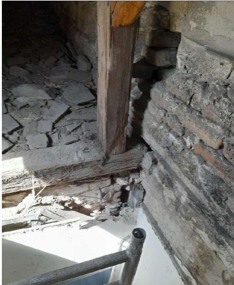
Gerendavégek veszélyes 3-4 cm-es feltámaszkodása !
