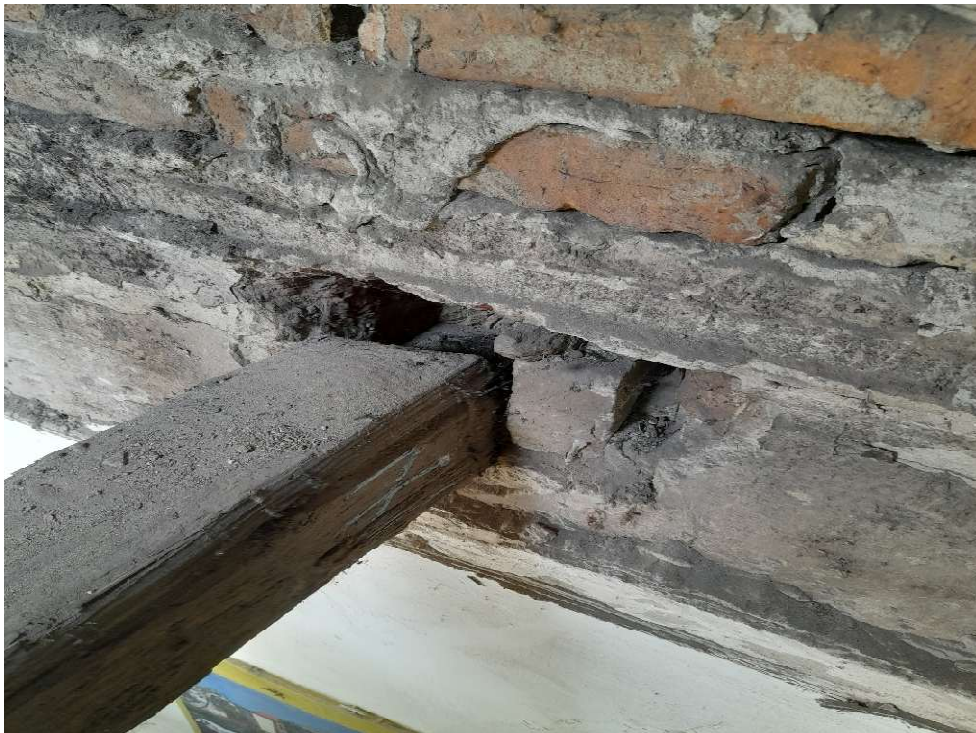
Gerendavégek veszélyes 3-4 cm-es feltámaszkodása !
